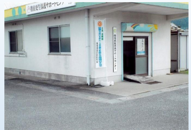
事務所北川出入口
