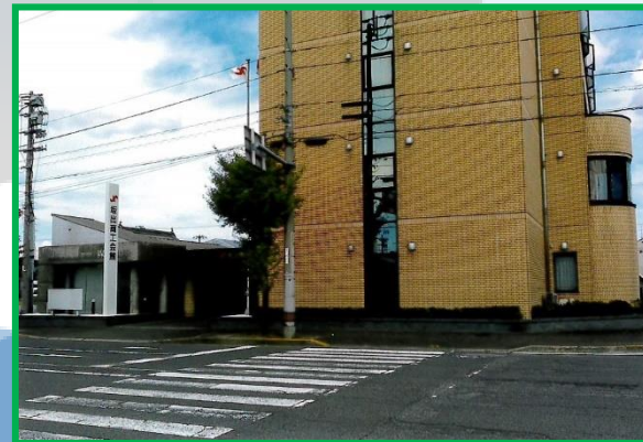
サポートセンターが入居している 坂出商工会館
