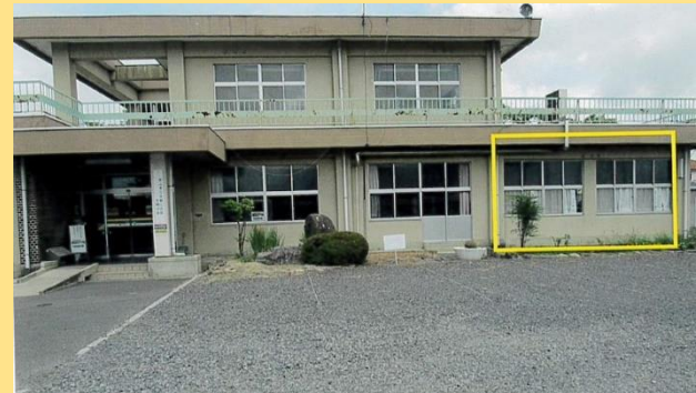
サポートセンター外観 (右側奥が事務室・会議室)
