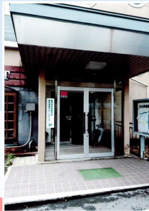
サポートセンター入居ビル入口
