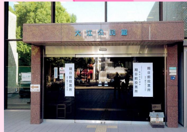
サポートセンター玄関・外観 (大江公民館玄関)
